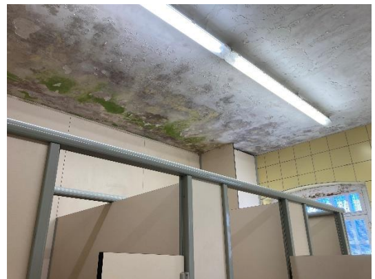
Plafond du bloc de douches
