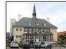
Dans les locaux de la commune: Rue E. De Brabant, 2
